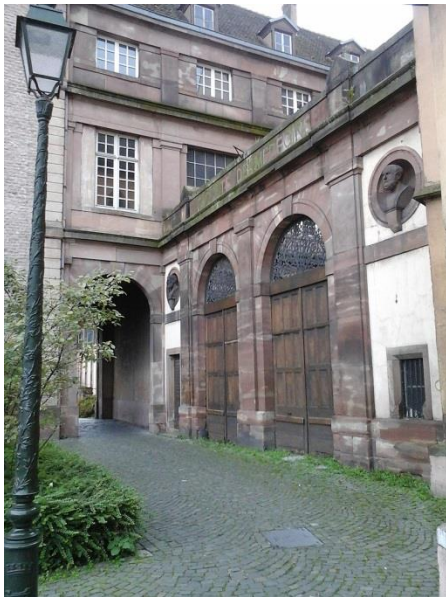
Porte de l'ancienne Faculté de médecine de Strasbourg créée en 1808
